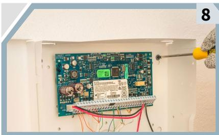
En este punto, has terminado de hacer todas las conexiones, es momento de **fijar el gabinete al muro**. Sigue el mismo procedimiento que aplicaste para empotrar los otros dispositivos.
