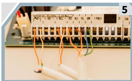
Para instalar el **teclado**, conecta los cables considerando la combinación de colores que hiciste en este dispositivo, ya que debe coincidir con la que conectarás en el panel en las **terminales con nombres de colores**.
