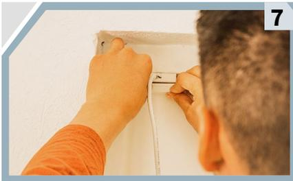
**Fija la parte móvil** del sensor a la misma altura que la parte fija y ¡listo!
