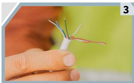
**Pela los cables** con un *cutter*: **3 cm (1.18 in)** de **ambos extremos**, es decir, retira con cuidado la parte plástica exterior para dejar los cables de colores descubiertos.
