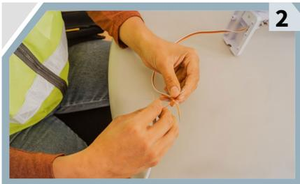
**Usa** cable UTP para alargar los cables de la sirena en caso de necesitarlo. Considera que el otro extremo del cable UTP es el que irá conectado al panel de control y debe tener la **extensión necesaria para que alcance**.
