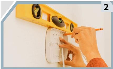
**Marca** en la pared donde vas a instalarlo, apóyate de un nivel de mano para asegurar que te quede derecho.
