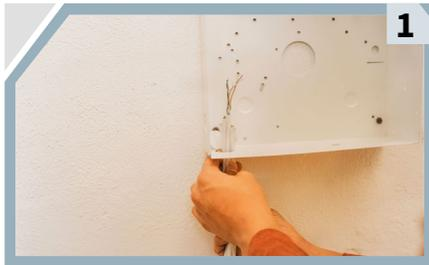
Pasa todos los cables UTP por el orificio del gabinete, después ya no podrás hacerlo y será imposible colocar el panel dentro.
