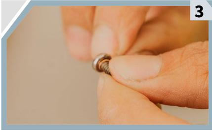
**Enrolla** el alambre de cobre de los cables en cada tornillo.
