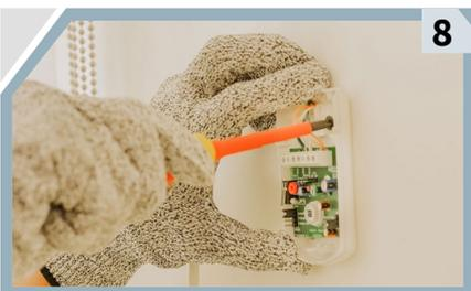
**Fija** el sensor con un par de tornillos y un desarmador.
